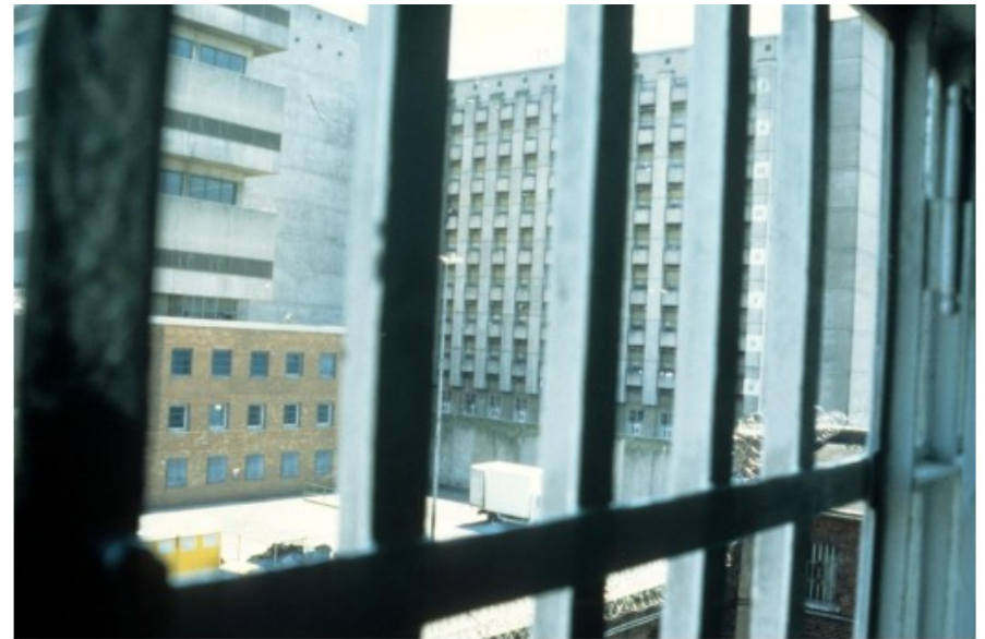
JVA Frankfurt am Main I, 1977-1997. Blick vom Kleinen Haus, 1889, auf Haupttrakt, Vollzugsgeschäftsstelle (unten) und Freihöfe mit Mehrzweckraum und Büros der Fachdienste
