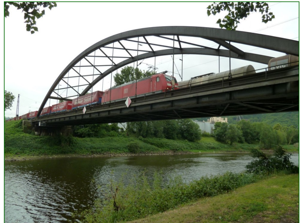
Brücken in Rheinland-Pfalz – karl-gotsch.de
